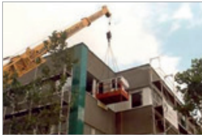
Kraneinbringung eines h/p/cosmos saturn®
