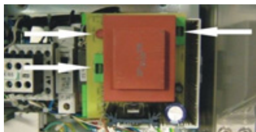
Säkringar i låda för strömförsörjningsenhet
