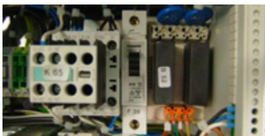
Sekundär säkring isoleringstransformator 1-polig B16A
