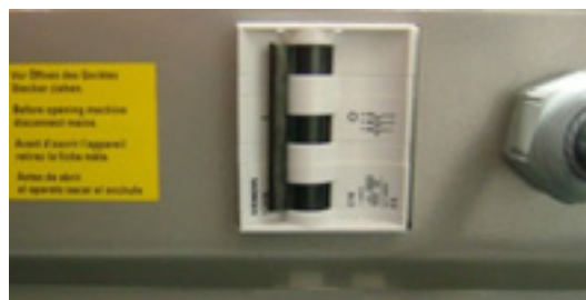
Säkring, enhetssäkring 3-polig C16A
